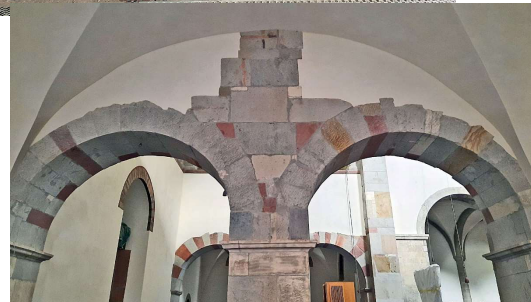
Sanierung Westwerk St. Pantaleon - 16.05.2022
